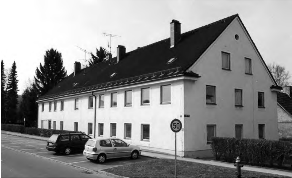
Oberbeuren, St. Cosmas-Straße 11, vor dem Abbruch im Jahr 2005
