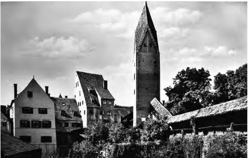
Gerberturm – Rückseite der Neuen Gasse
