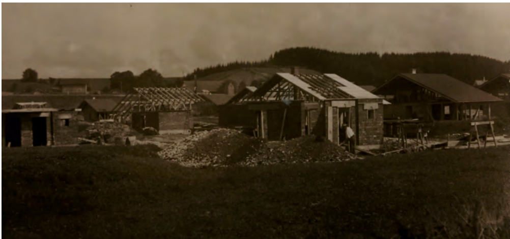
Bau der NSKOV-Siedlung, StadtA KF A 102 782
