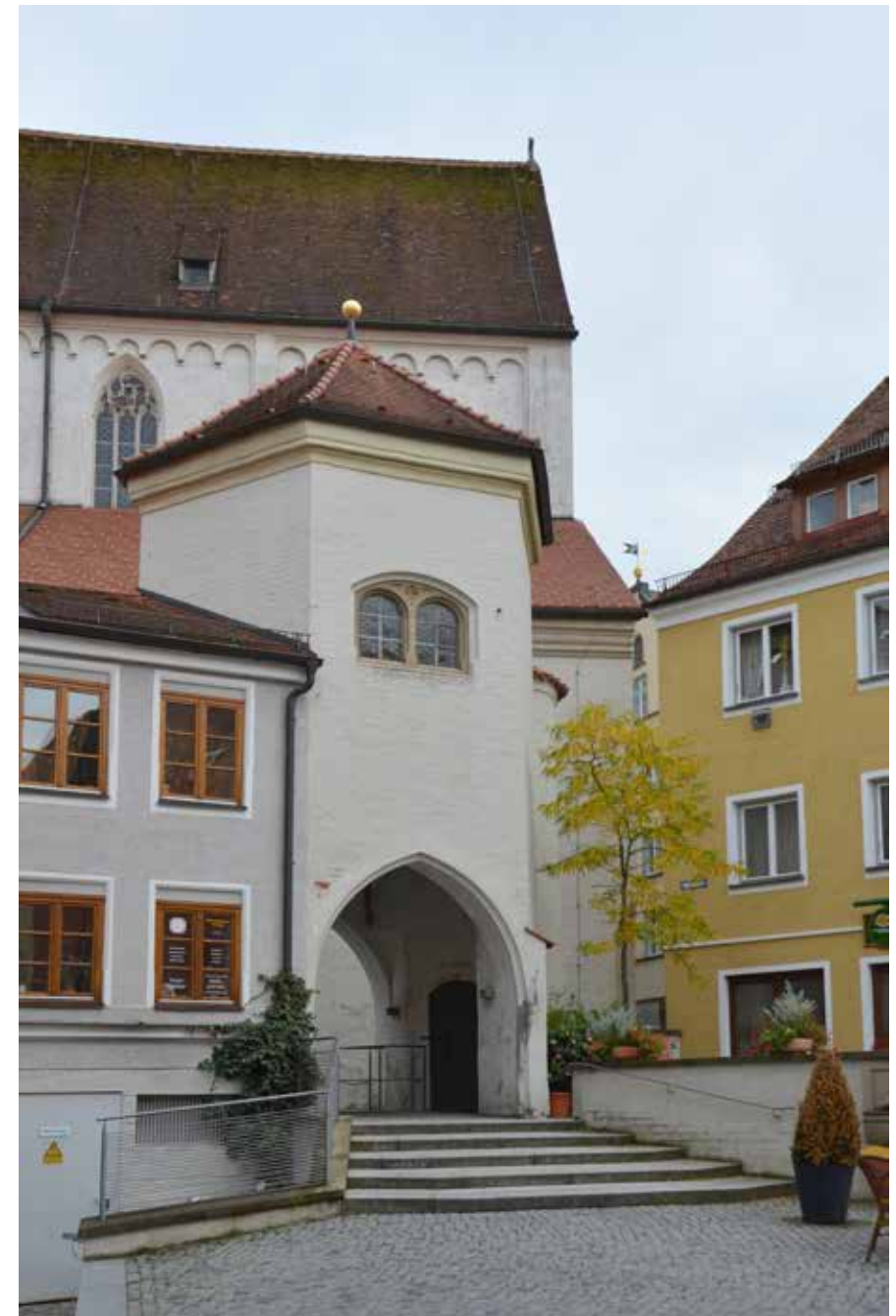
Münzturm - belegt seit ca. 1430 - Tresorraum der Kirchenstiftung - war ursprünglich auf der Nordseite geschlossen - wurde erst vor einigen Jahren durchbrochen und zum Durchgang geöffnet.
