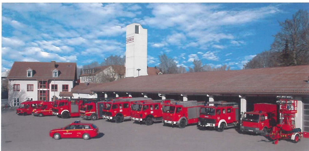
Hauptfeuerwache Kaufbeuren an der Neugablonzer Straße:
