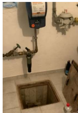
Bsp. Putz-/Kontrollöffnung im Keller
