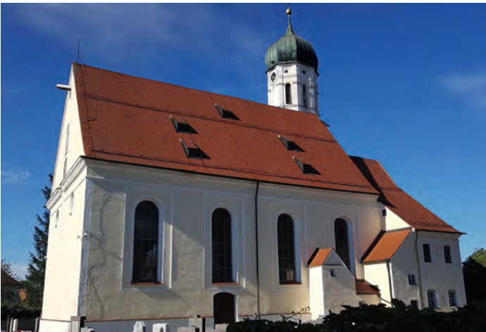
Pfarrkirche St. Johannes der Täufer zu Asch
