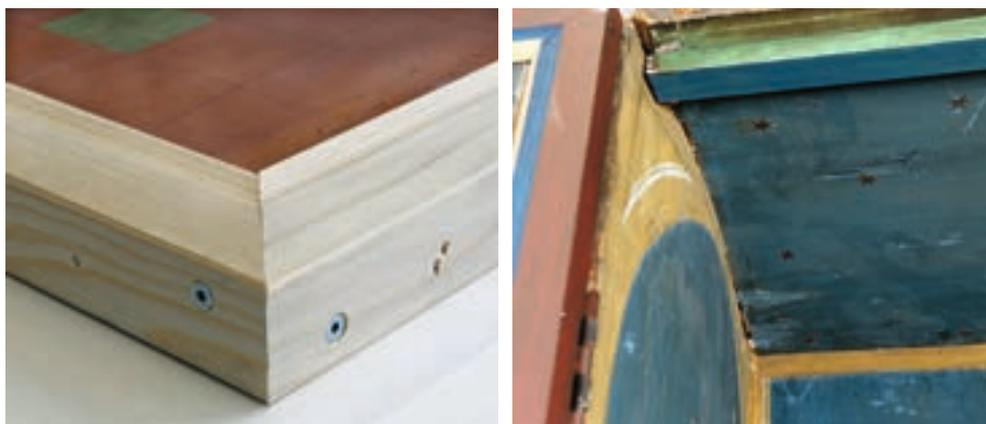
*Abb. 68: geschraubte Eckverbindungen*
