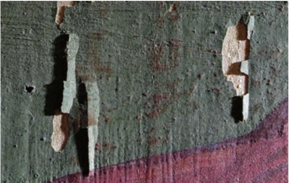
*Abb. 59: Fehlstellen und Malschichtlockerungen*
