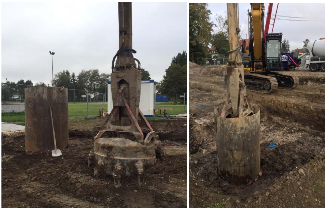
Bilder: Brunnengründung mittels Stahlrohren und Polypgreifer in Talkiesen und Tallehmen, Memmingen
