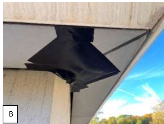
Abbildung 4: Hohlraum an einer Gebäudeecke auf der Nordseite vor (A) und nach dem Verschließen (B).
