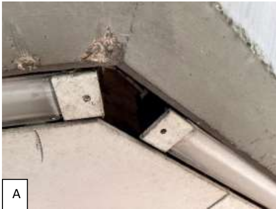
Abbildung 3: Hohlraum zwischen Beleuchtungselementen am Eingangsbereich der ehemaligen Postbank vor (A) und nach dem Verschließen (B).
