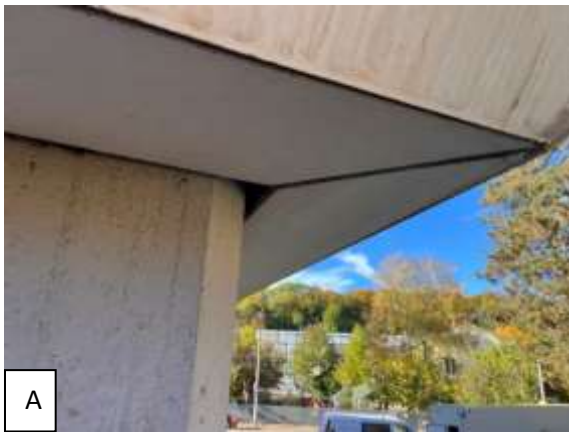
Abbildung 4: Hohlraum an einer Gebäudeecke auf der Nordseite vor (A) und nach dem Verschließen (B).
