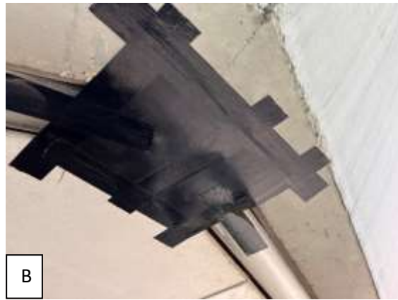
Abbildung 3: Hohlraum zwischen Beleuchtungselementen am Eingangsbereich der ehemaligen Postbank vor (A) und nach dem Verschließen (B).
