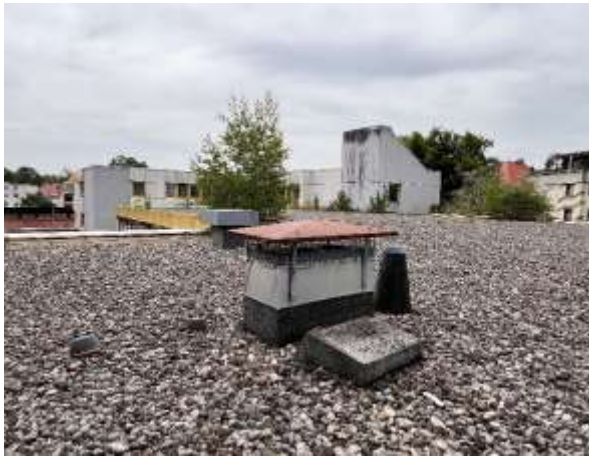
Abbildung 18: Dachbereich des nordwestlichen Gebäudes.
