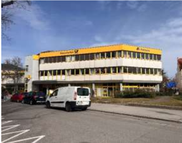
Abbildung 9: Hauptgebäude der Postbank (Ansicht Süd).
