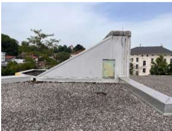
Abbildung 16: Dach des südlichen Gebäudeteils.
