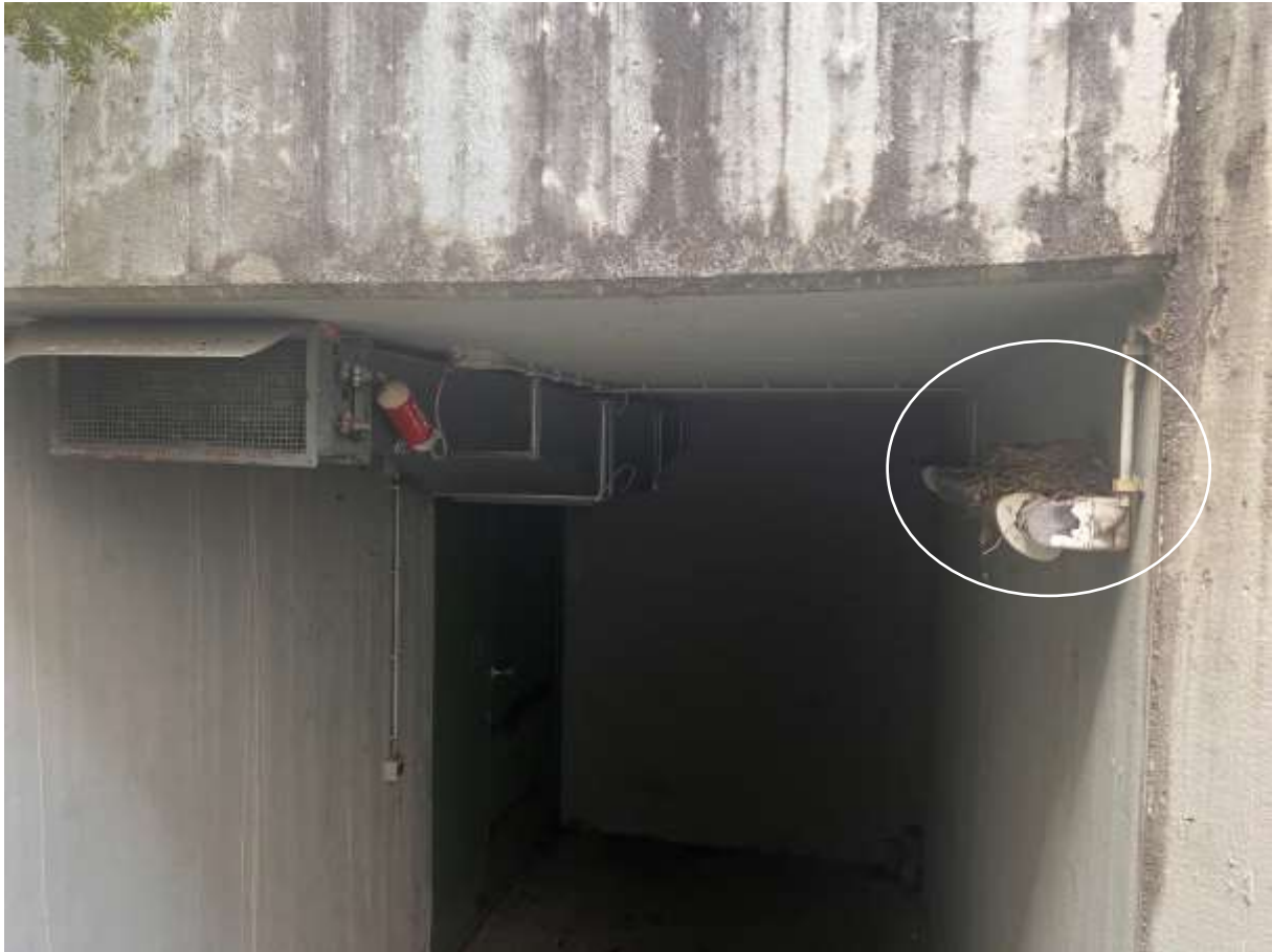
Abbildung 15: Voraussichtliches Nest einer Amsel am Treppenabgang auf der Nordseite zum Nebengebäude.
