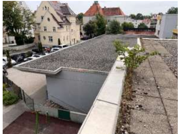
Abbildung 19: Dachbereich des nordöstlichen Gebäudes.
