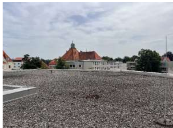
Abbildung 17: Weiterer Dachbereich des südlichen Gebäudes.
