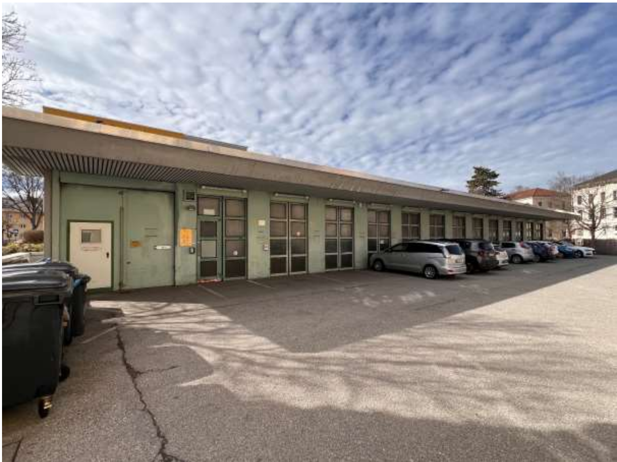
Abbildung 11: Gebäude zur Anlieferung mit 13 Toren.
