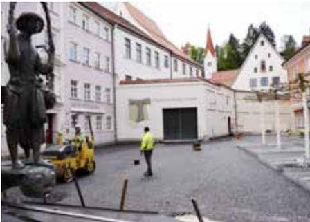
Als Untergrund für das Pflaster wurde Mitte Mai eine wasserdurchlässige Asphaltschicht aufgetragen.
