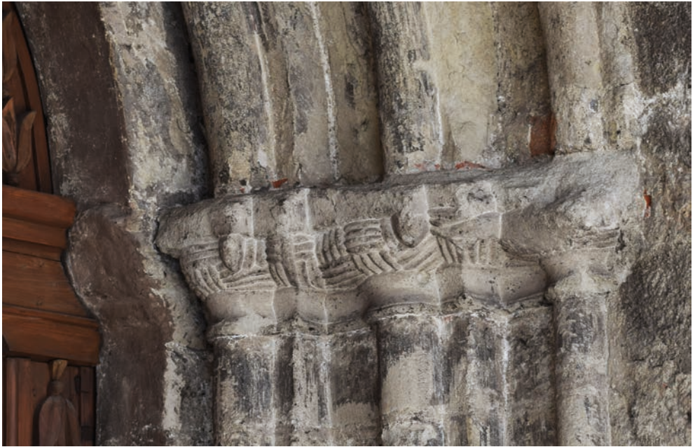
Die romanischen Kapitelle am Haupteingang
