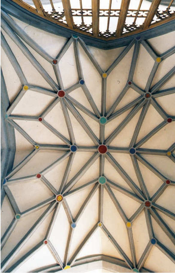
Blick in die Netzrippen an der Decke des südlichen Seitenschiffs
