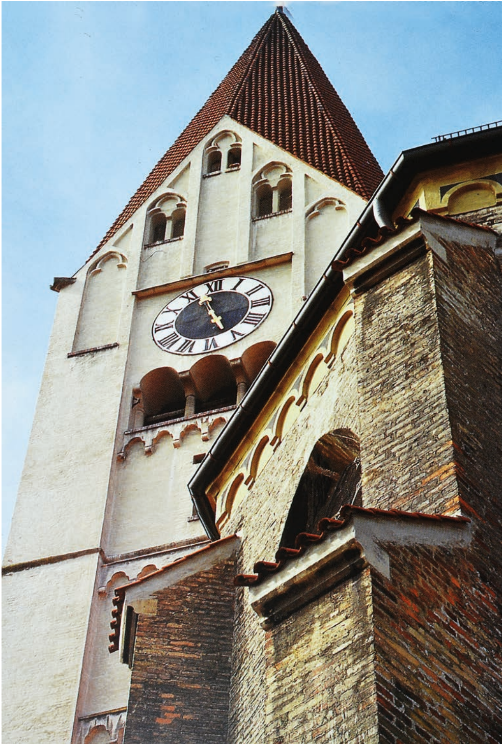
Blick von Südosten über den Chorraum zum Turm
