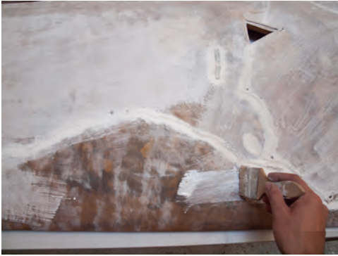
Über die Vorleimung und angeböschten Hautkanten wird die erste Grundierungsschicht aufgetragen.
