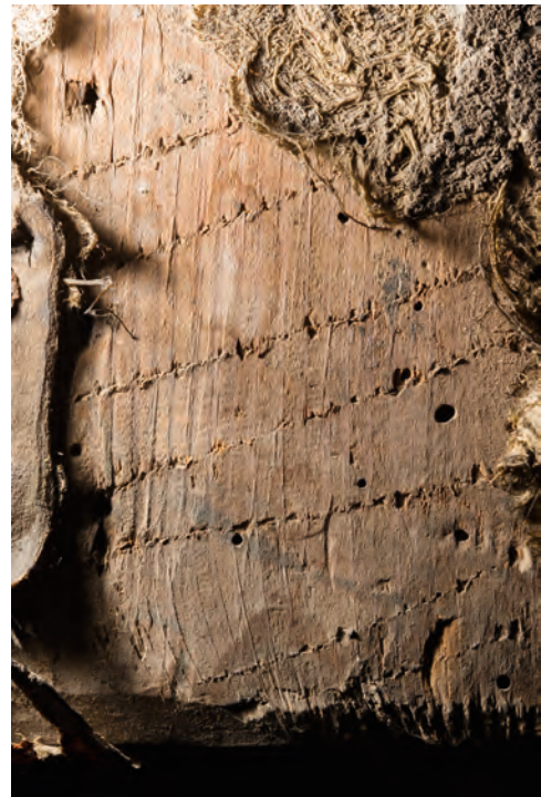
Im Streiflicht schwach erkennbare Hobelspuren (im Bild senkrecht verlaufend) und Ritzungen
