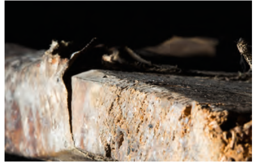
Flach abgefaste Schildunterkante
