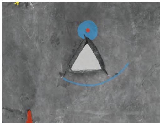
Die Kontur der Kratzspuren geben die Außenmaße der Abdeckung des Sichtfensters vor.
