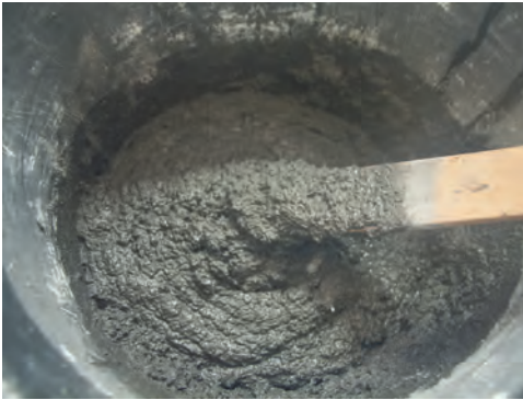
Die mit Leim verrührte Masse besitzt in etwa die Konsistenz von Mörtel und lässt sich ähnlich wie dieser mit einer Kelle auftragen.
