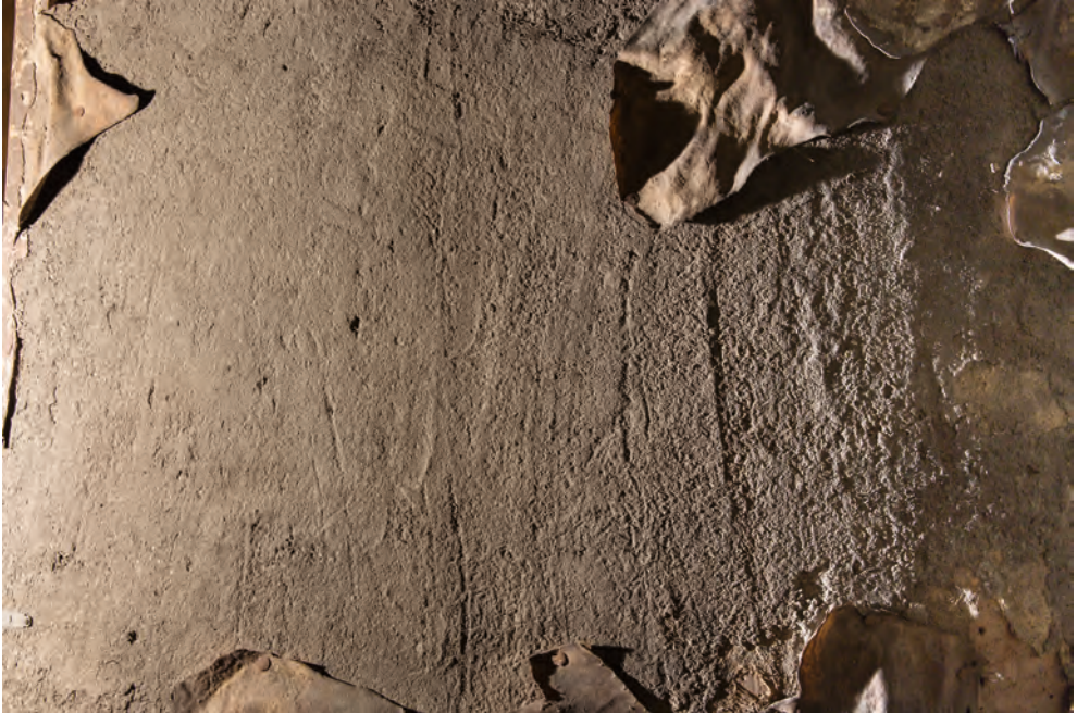
Freiliegende Zwischenschicht im Streiflicht. Gut sind Grate und Vertiefungen in der Schicht zu erkennen.
