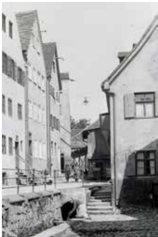
Blick durch die Straße unter dem Berg zum Wassereinlaß der oberen Überschlagmühle
