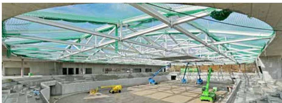
Nimmt bereits Formen an: das neue Eisstadion, künftig erdgas schwaben arena
